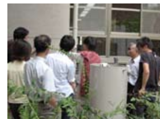
7月18日設置中の雨水タンク
